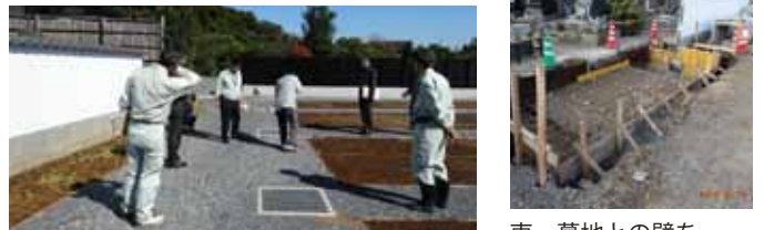
10月17日 柏市職員による竣工検査
